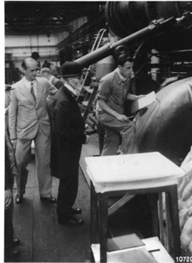
Ve strojovně první spalovací turbíny: Rok 1939 – pán s buřinkou je Aurel Stodola – velká trubka nad hlavou pracovníka úplně vpravo je spalovací komora.
