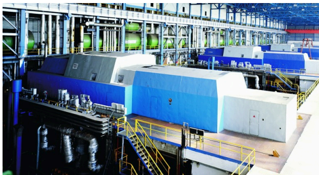
168: Uspořádání turbosoustrojí 4x200 MW ve strojovně elektrárny Dětmarovice Obrázek z [ČEZ, a.s., 2011. Majitel a provozovatel elektráren. Adresa: Praha 4, Duhová 2/1444, PSČ 140 53, Česká republika, http://www.cez.cz .]
